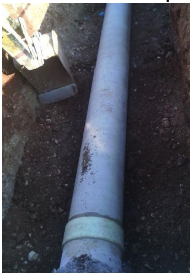
Tubazioni interrate in pressione
