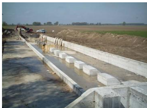
Argine fusibile in fase di costruzione
