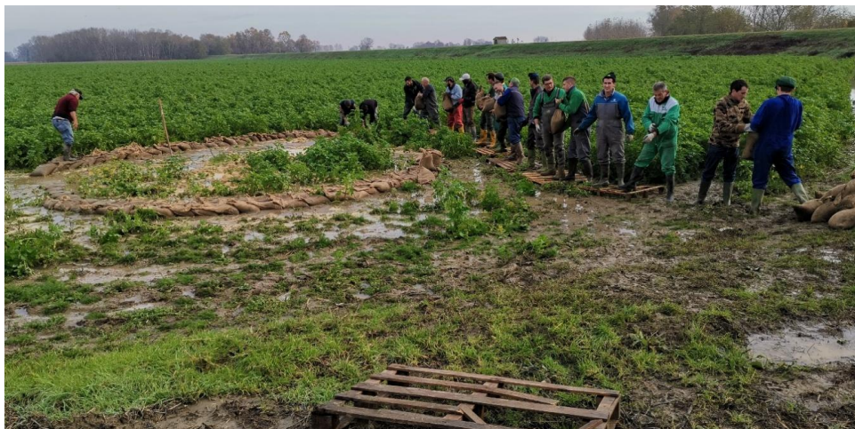
Controllo di un pericoloso fontanazzo mediante formazione di vasca di compensazione composta con sacchi di sabbia costituiti e posizionati a mano
