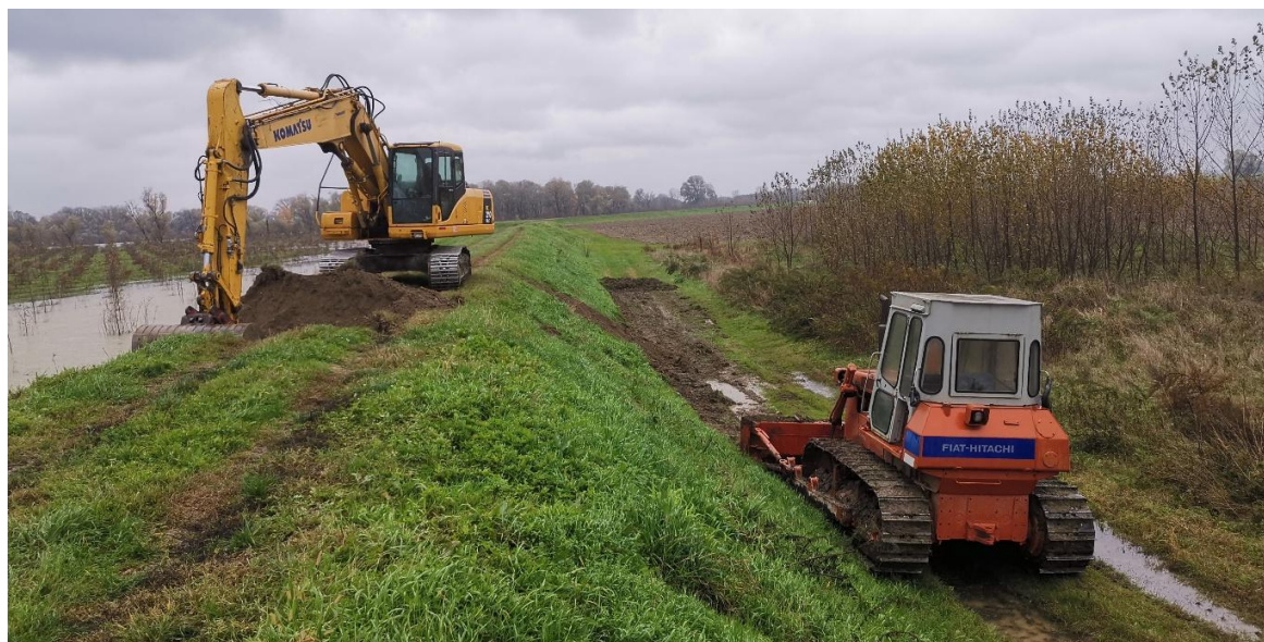
Apertura con mezzi meccanici di arginatura fusibile
