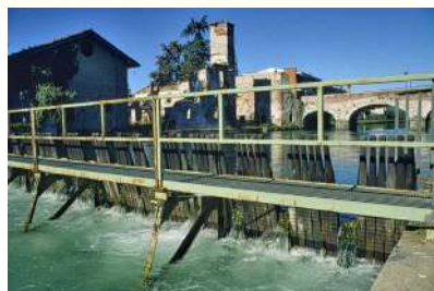
♦ La vecchia diga "a paladelle" sul Naviglio Grande a Turbigo.
