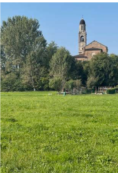
♦La chiesa parrocchiale di Castelleone e, sotto, una veduta della chiesa di Ripalta Arpina.
